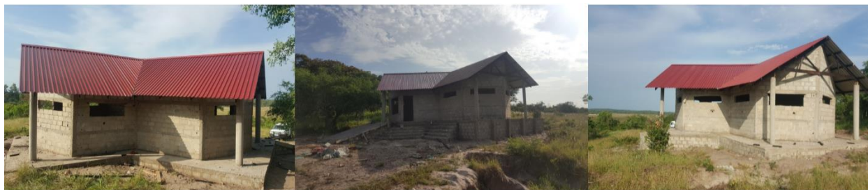
Figura 1: Detalhes da obra de construção do Centro de Processamento de Mel – segunda parte da Fase II das Obras de Construção
